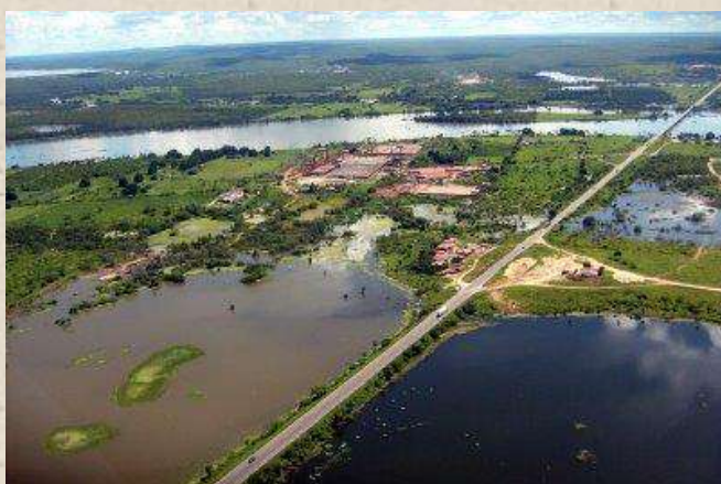
Danos ocasionados por enchentes
